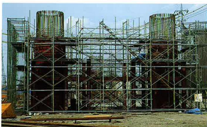
標準サイズのメタルフォームと異形メタルフォームの組み合わせで、極めて簡易に正確、堅固な型枠が組立てられます。曲面・円の利用はますます増えてきており、円形型枠は巾広い用途があります。
