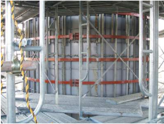
円柱 (外枠) 用 縦に単管パイプを抱き込んでご使用下さい。
