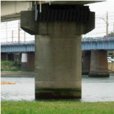
高速道路、鉄道の橋脚の新設や耐震補強
