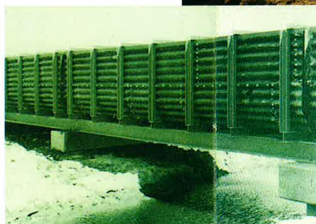
高架フリューム
