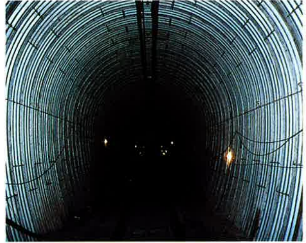
トンネル(馬蹄形アーチ)
