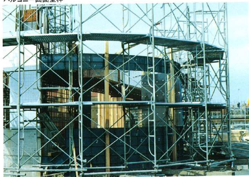
バルコニー曲面型枠
