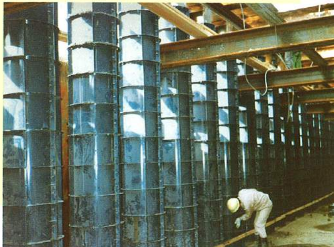
H型鋼根巻型枠
