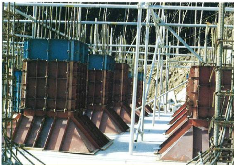
処理場下部ハカマ型枠(角形)
