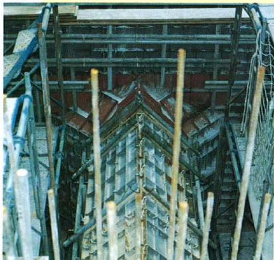
処理場異形梁型枠
