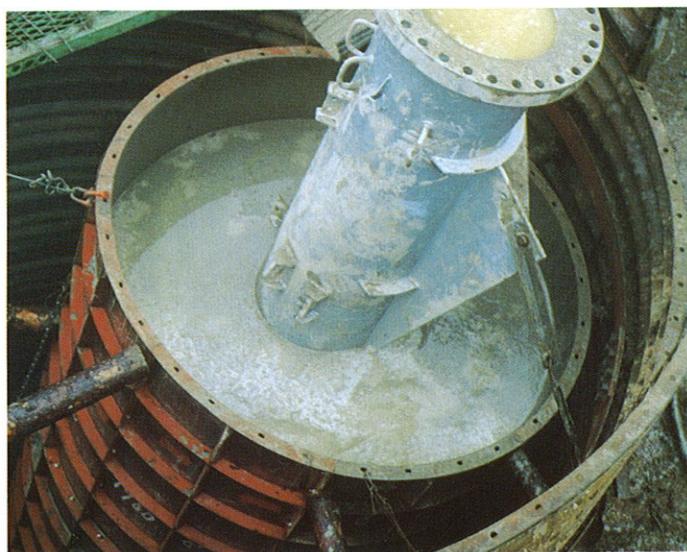
VI型基礎型枠
